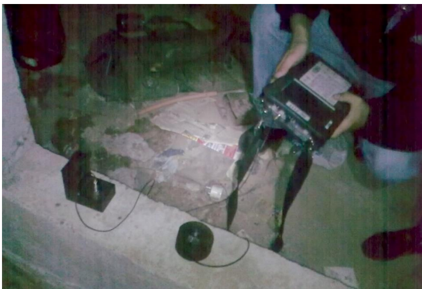
Рис. 4.4. Вимірювання вібрації на стіні підвалу
